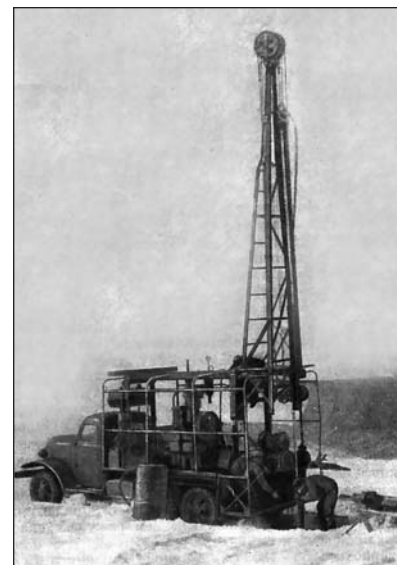
Самоходная буровая установка СБУ-150-ЗИВ на шасси автомобиля ЗИЛ-151 использовалась для колонкового бурения на леднике Чурляниса (архипелаг Земля Франца-Иосифа, 1957—1959) [11].
